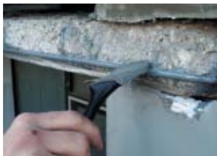
3) Ošetření výztuže propojovacím a ochranným nátěrem ARDEX FB
