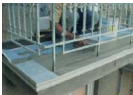
2) Položení drenážní rohože a lepení dlažby s ARDEX FB 9L
