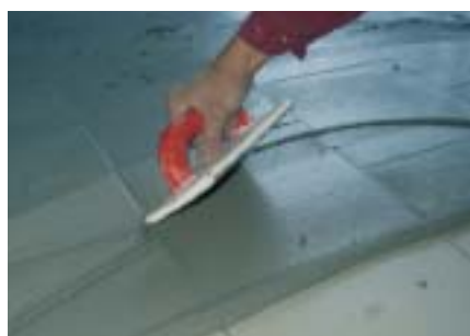
3) Spárování dlažby s ARDEX FL nebo FF
