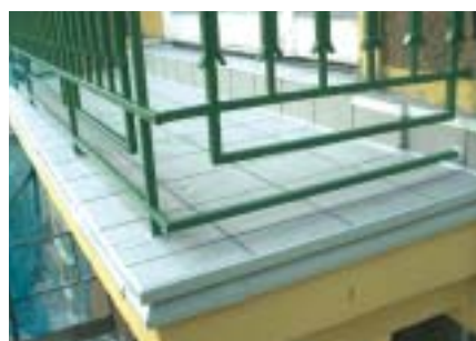
3) Spárování dlažby s ARDEX FL nebo FF
