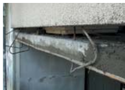
4) Hrubé vyspravení železobetonové konstrukce ARDEX B14 s přidáním až 40% křemičitého písku
